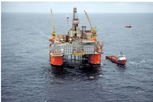
Snorre A-plattformen, som kom i produksjon i 1992, er en integrert bore-, prosesserings- og boligplattform som også prosesserer olje fra undervanns-innretninger på feltet og olje fra Vigdis-feltet. Transportløsningen er knyttet opp mot Statfjord-feltet. Produksjonen på Snorre B-plattformen startet i 2001. Snorre har betydelige gjenværende ressurser.
