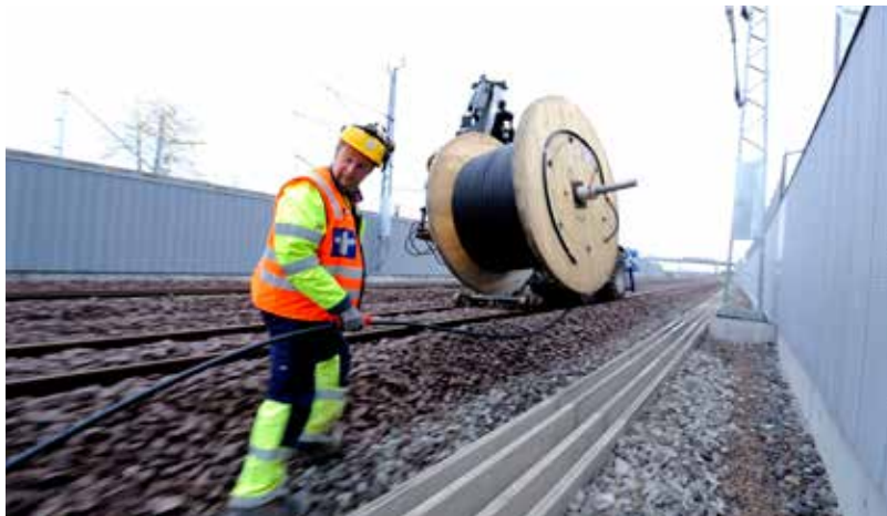
Det legges signalkabel mellom Barkåker og Tønsberg.
