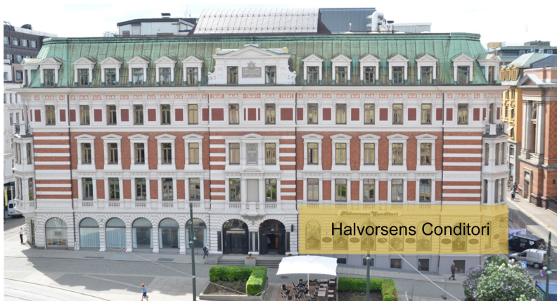
Fasaden før rehabilitering og plassering av Halvorsen Conditori. Foto: Stortinget
