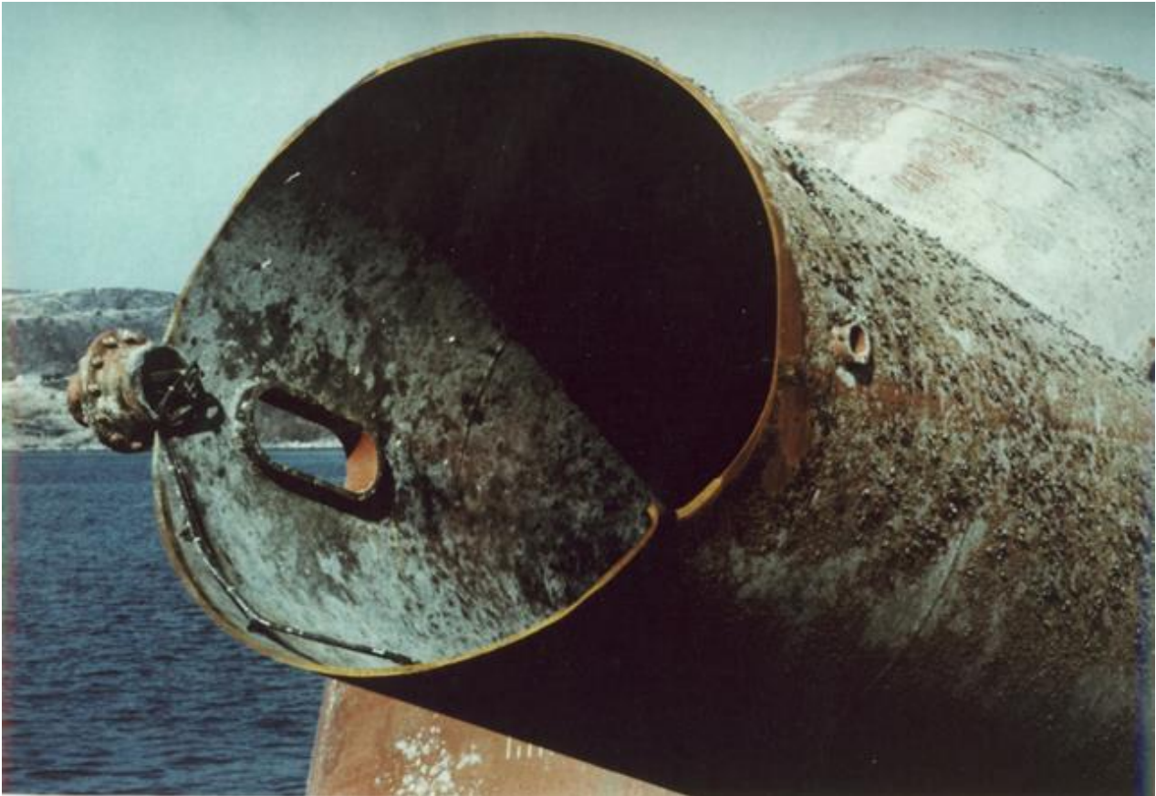
Bruddflate på D6-staget på Alexander L. Kielland. Foto: Bjørn Lian.
