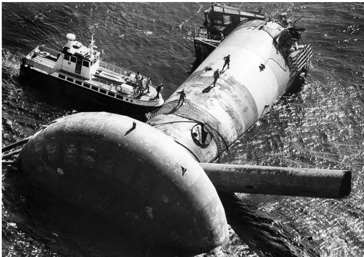
Det avbrukne plattformbeinet på Alexander L. Kielland blir undersøkt. Foto: Egil Eriksson / Stavanger Aftenblad.
